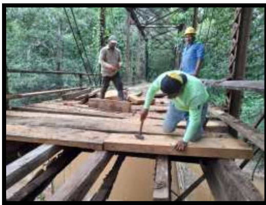
Imagen 1. Reparación del Puente
