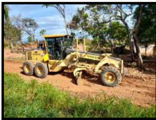
Imagen 2. Mantenimiento de Camino
